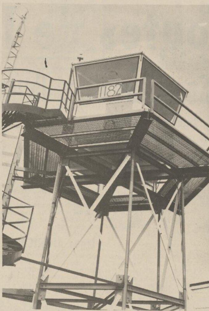
LA TOUR DE CONTRÔLE de l'aéroport de Saint-Jean, qui s'élève à quarante pieds du sol, a été rénovée en mai dernier. L'escalier, qu'on aperçoit à gauche, remplace une échelle. À l'intérieur, deux techniciens s'occupent constamment de diriger la circulation aérienne au moyen d'appareils des plus modernes, faisant environ 350 opérations par jour.
