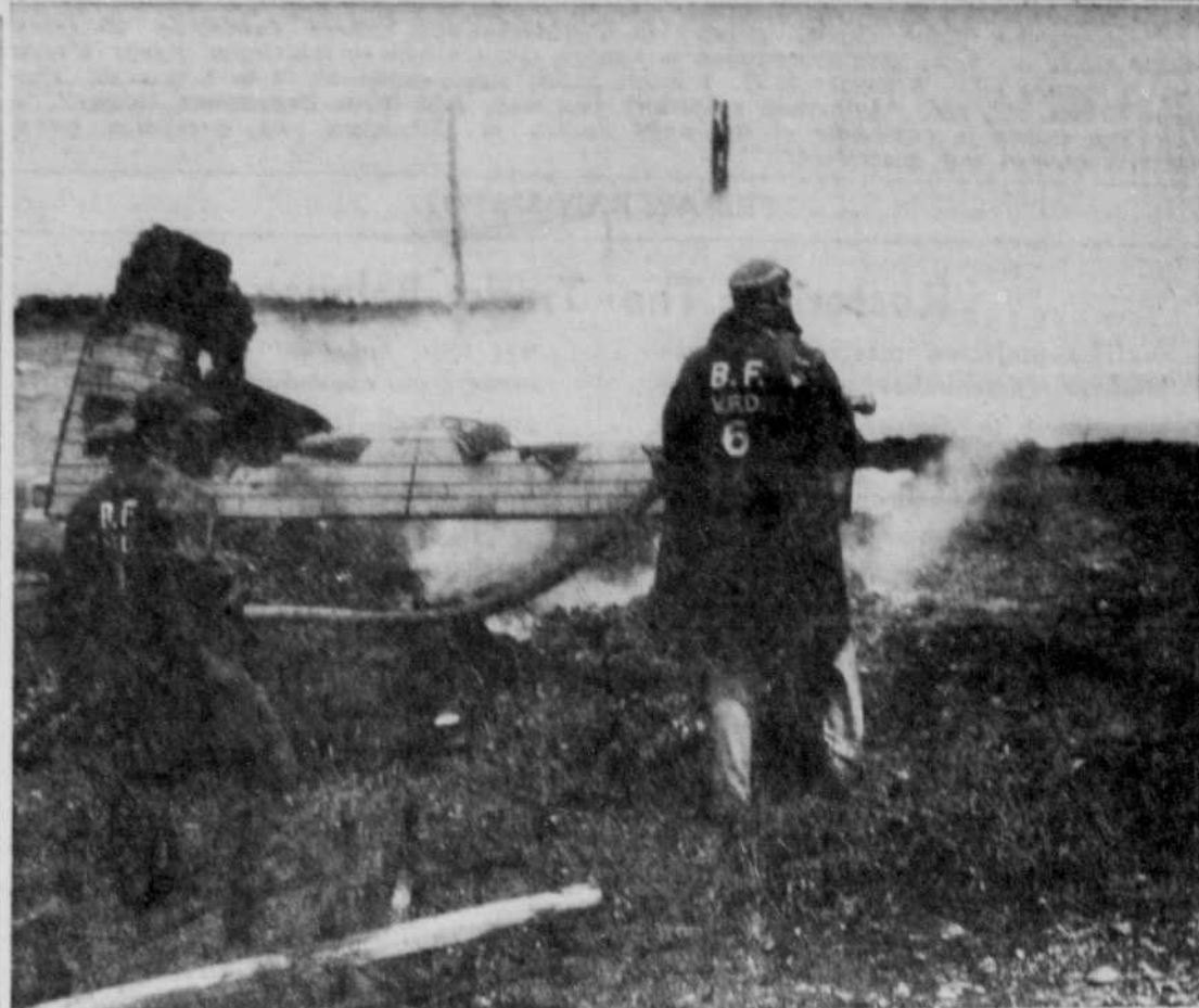
BEECHER FALLS, VERMONT, FIREMEN POUR WATER ON RUINS
