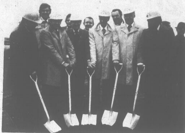
DEBUT DES TRAVAUX
