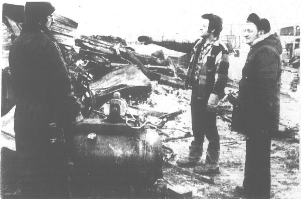
M. Marcel Cameron, fils de Fernand, montre l'endroit où le feu aurait pris naissance. Au premier plan un compresseur d'une valeur de $3,000 faisait partie de l'outillage remis au sous-sol.
