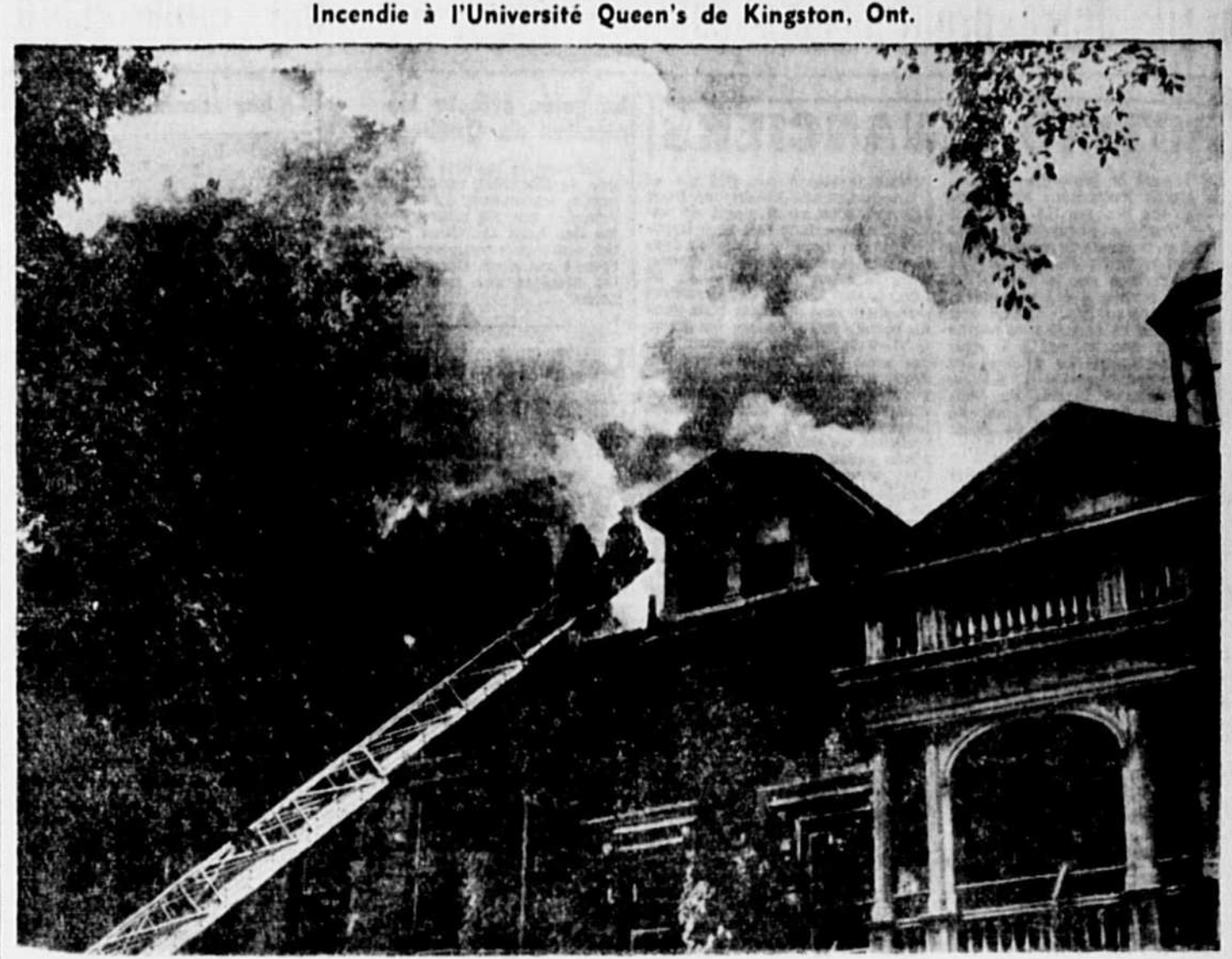
Incendie à l'Université Queen's de Kingston, Ont. Quelques heures seulement avant sa réouverture, la maison des étudiants de l'Université de Kingston a été le théâtre d'un incendie. Bien que les flammes furent rarement vues de l'extérieur durant l'incendie, les dommages s'élevaient entre $50,000 et $80,000. On voit ici deux pompiers, au haut d'une échelle mécanique, combattant les flammes par une fenêtre. Tous les pompiers de Kingston furent mandés sur les lieux afin de parer à toute éventualité.
