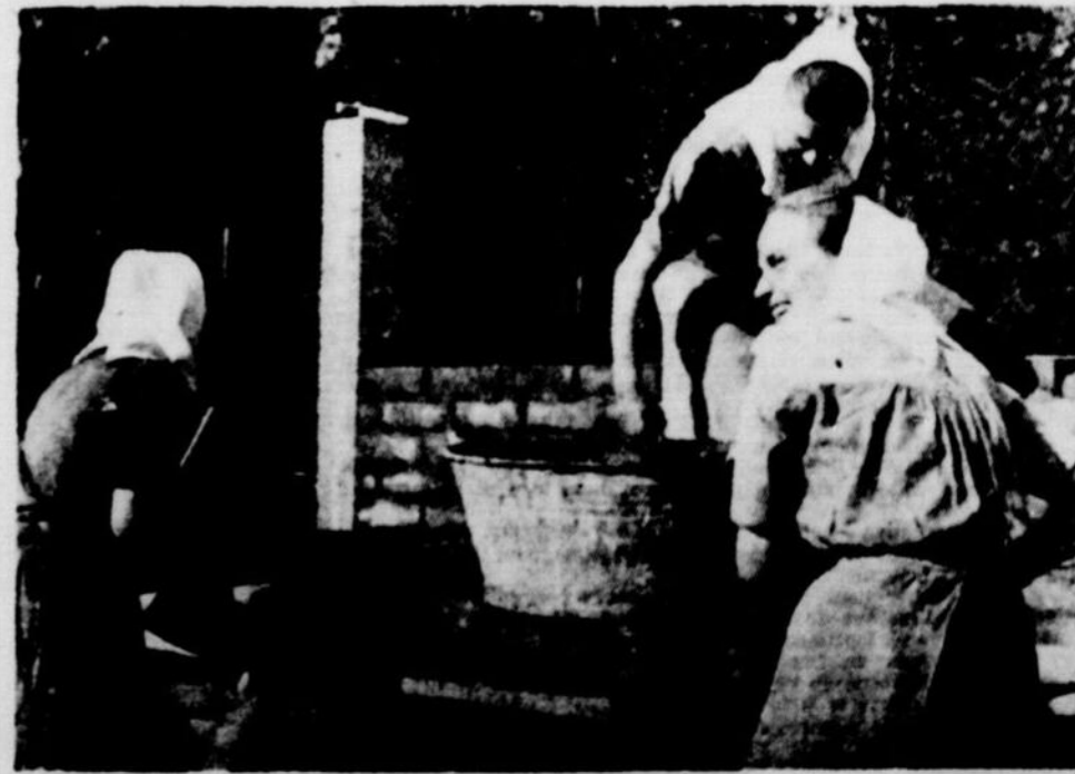
Les religieuses s'occupent de construire elles-mêmes les murs de leur couvent et de leur cour intérieure. Ici on a déposé du ciment dans une cuvette et on pose les briques une à une, tout en priant.
