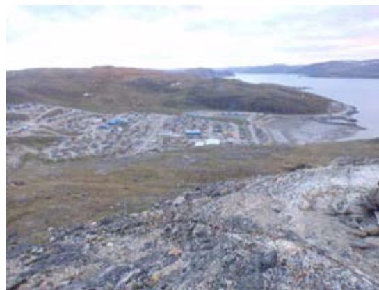
Figure 4 : Construction des infrastructures sur des importants remblais granulaires
