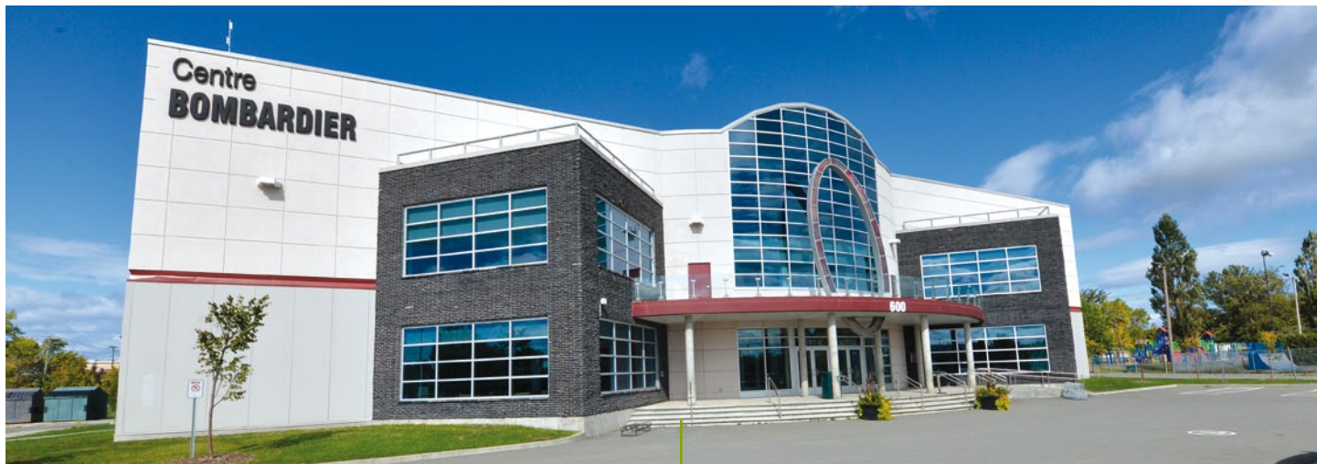
Centre Bombardier de La Pocatière, une réalisation de Kamco construction
