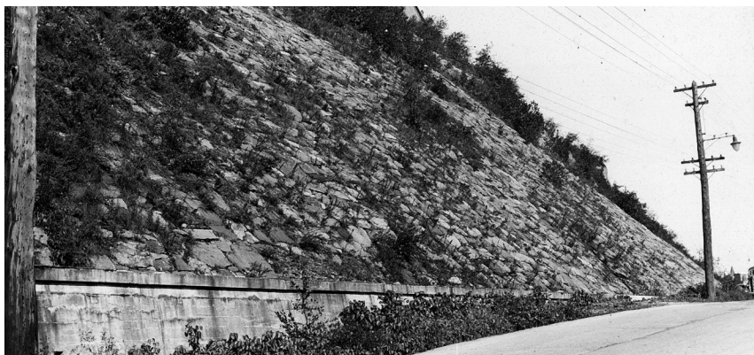
Figure 5 : Vue du mur de soutènement sur la rue Champlain.
