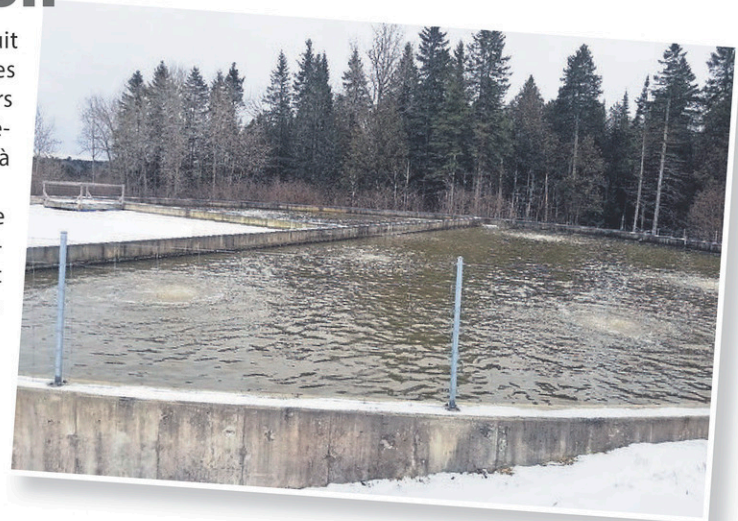
Une vue rapprochée des trois cellules du bassin à Saint-Frédéric où sont traitées en différentes étapes les eaux usées municipales. (Photo gracieuseté)
