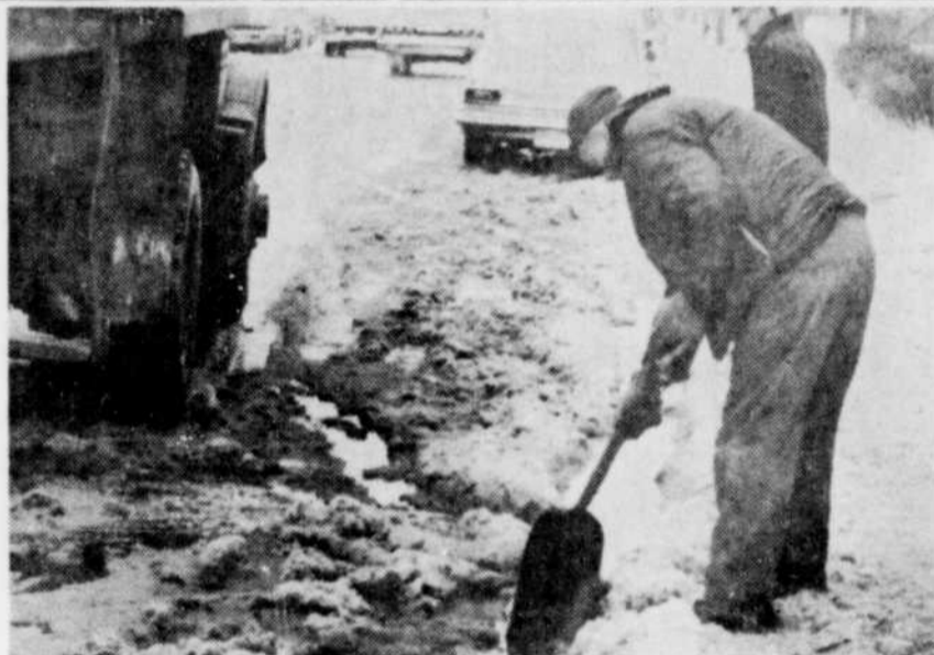
Les employés de la voirie ont dû momentanément oublier l'enlèvement de la neige pour se consacrer à faire couler l'eau dans les bouches d'égout. (Photo La Tribune, par Studio Breton)
