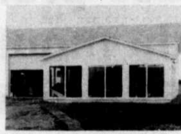
Vue extérieure de Réparation Pilon aux termes de l'agrandissement!
