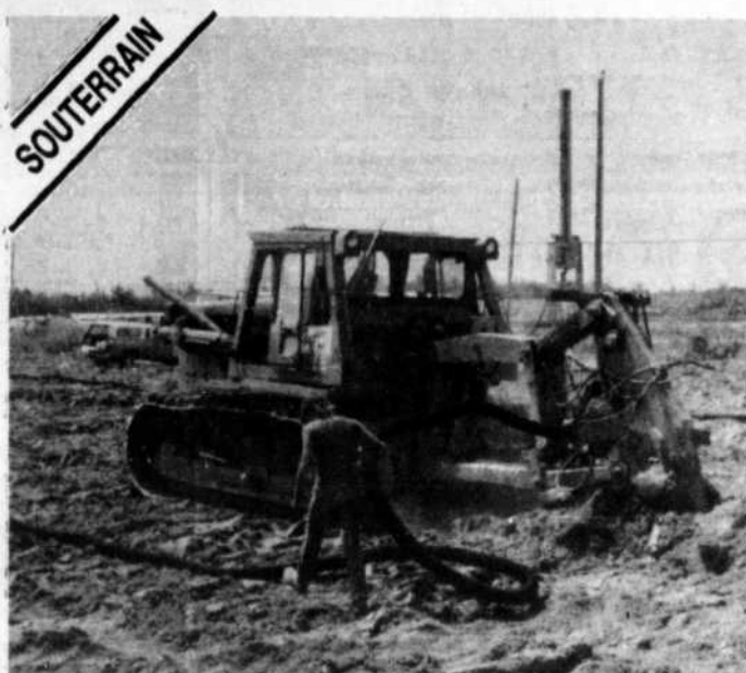
Équipé d'une taube pour l'installation de tuyaux souterrains.
