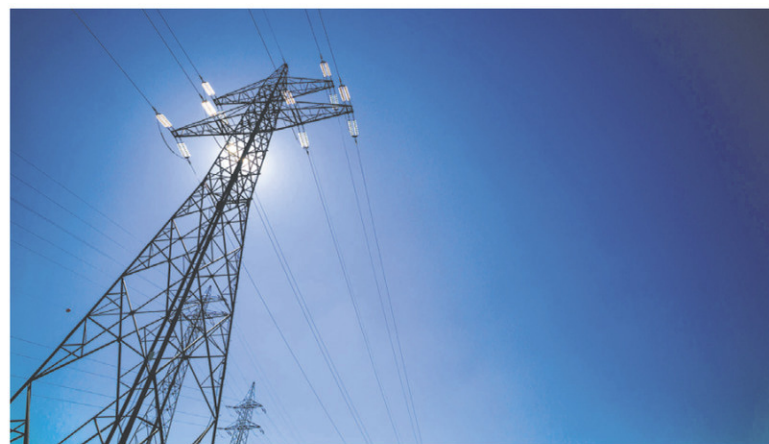
WSP : EN AFRIQUE, LE PROJET DE RUSUMO FALLS, CONSTRUCTION DE 380 KM DE LIGNE DE TRANSMISSION D'ÉLECTRICITÉ ET DE 4 SOUS-STATIONS RELIANT 3 PAYS
