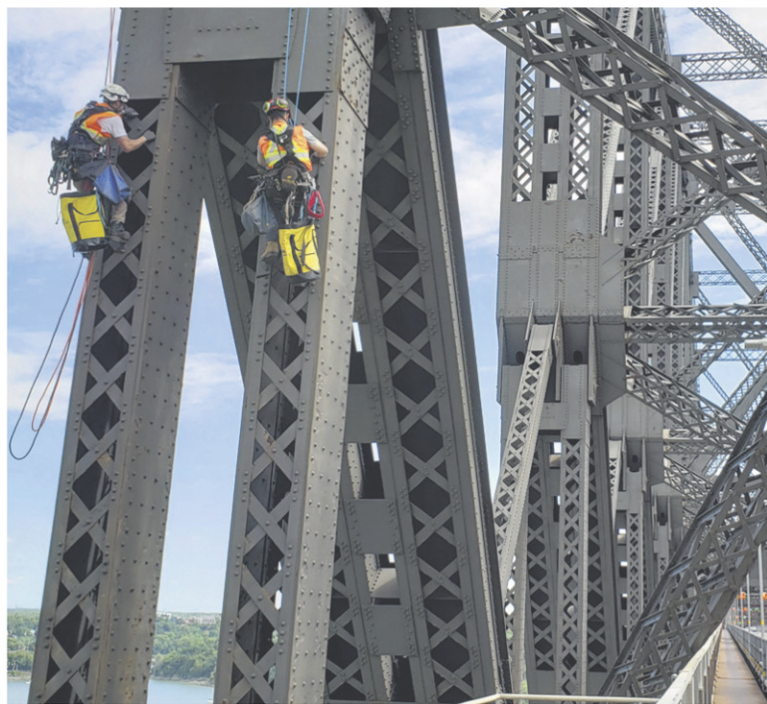
INSPECTION DU PONT DE QUÉBEC
