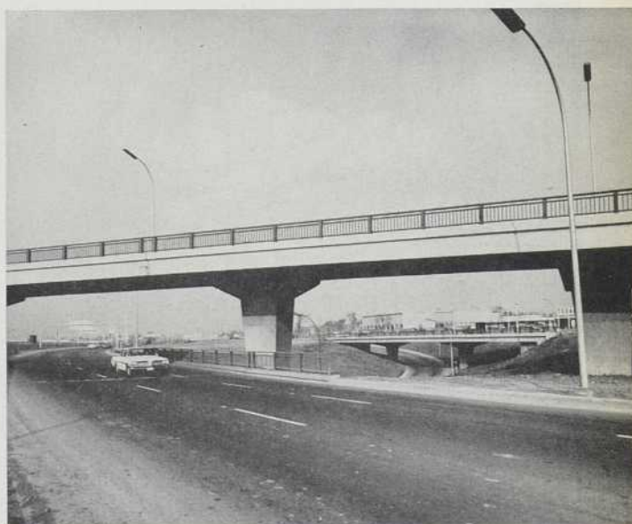
Etagement de voies à trois niveaux, à l'endroit où le viaduc de l'autoroute du Nord enjambe la voie rapide du Boulevard.
