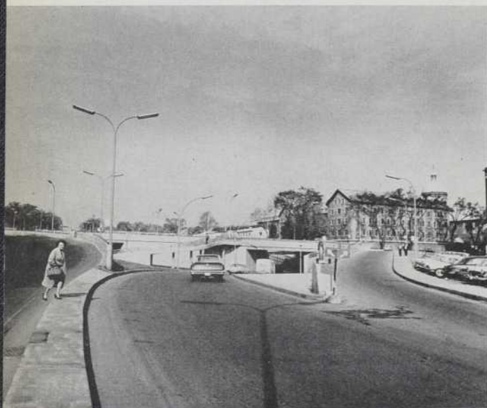
Vue de l'avenue du Parc, du sud vers le nord.
