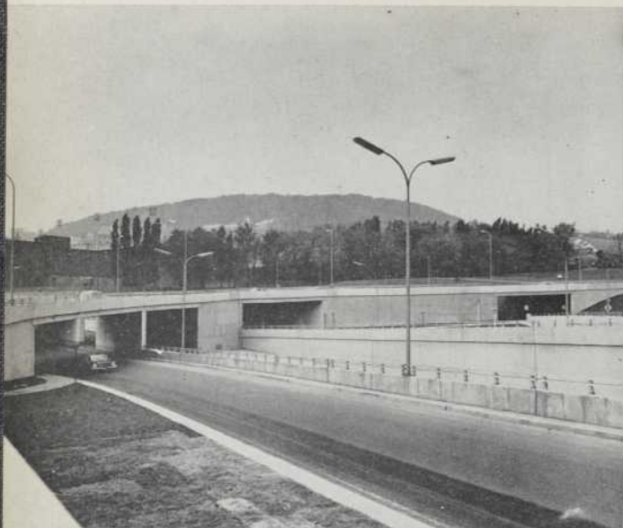
Voie étagée allant de l'avenue des Pins à l'avenue du Parc.
