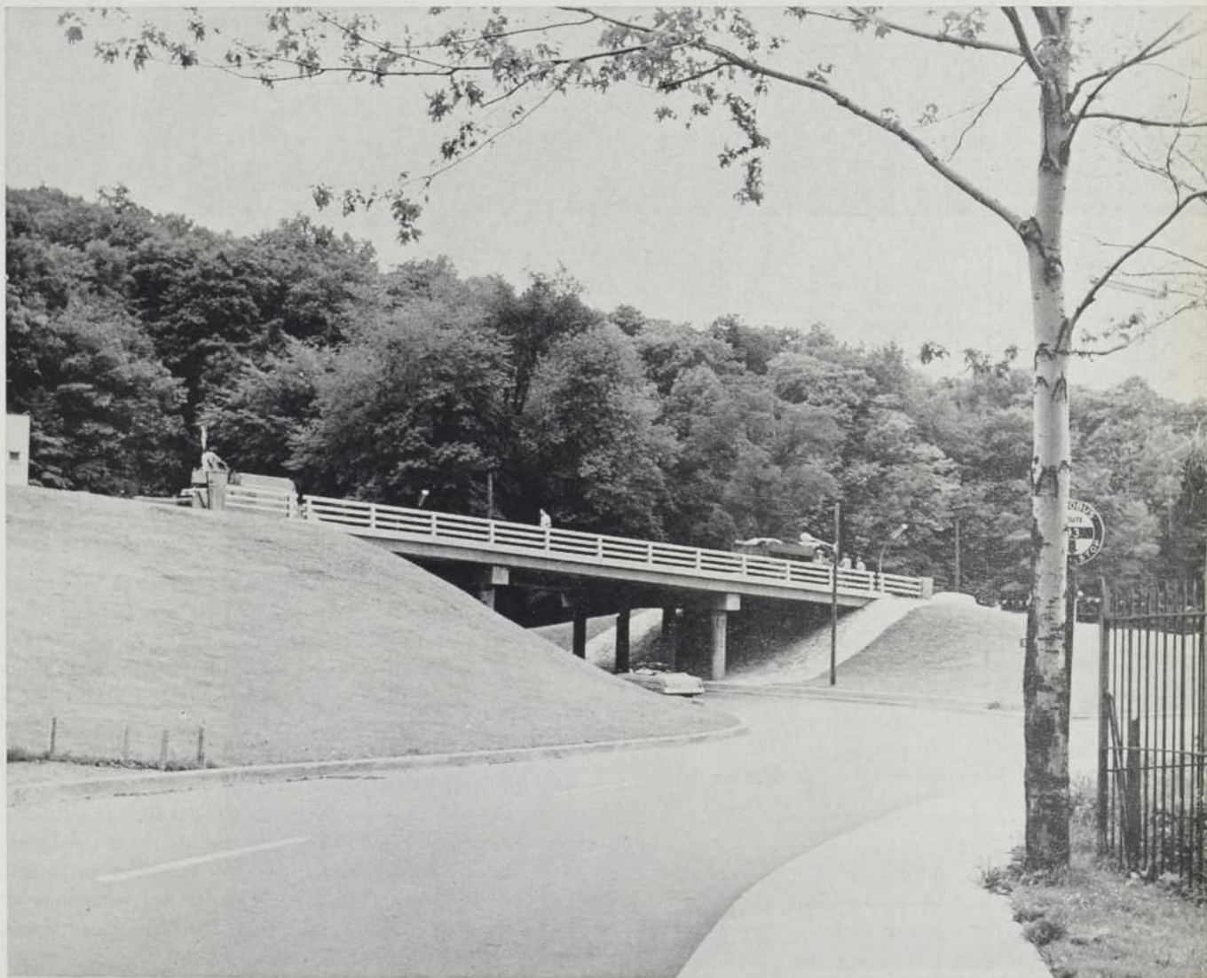
Photo du Service des Travaux Publics
