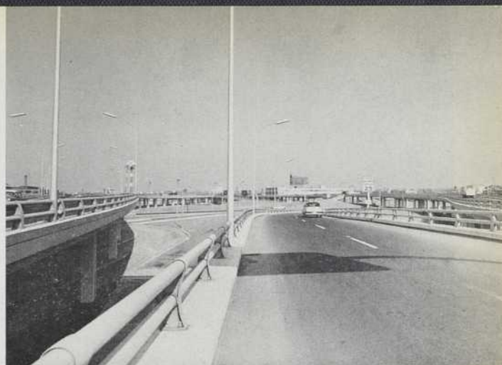
Vue prise de l'une des voies élevées, aux approches du Rond-Point Décarie.
