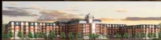
SAINTE-JULIE (EN CONSTRUCTION)
