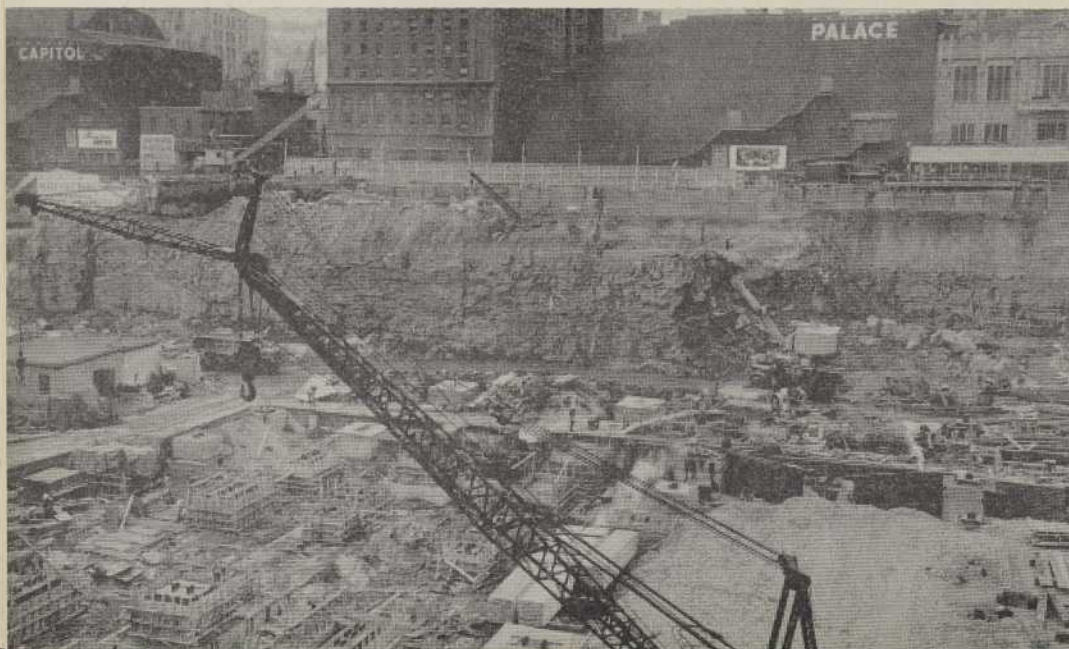
UNE DES SECTIONS DE LA FUTURE PLACE VILLE-MARIE, À MONTRÉAL; AU FOND, L'ÉNORME BLOC DE ROC QU'ON EST EN TRAIN DE FAIRE SAUTER.
