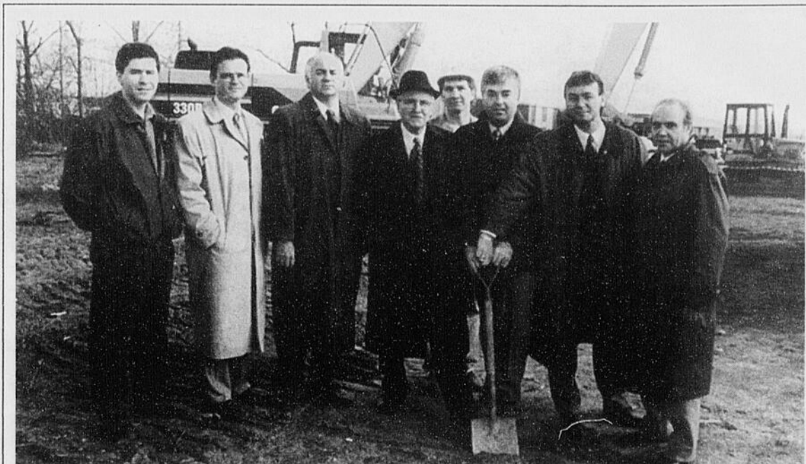
C'EST PARTI ! - Les représentants de la Caisse populaire Desjardins de Saint-François-Xavier de Chicoutimi procédaient récemment à la levée de la première pelletée de terre, donnant ainsi le coup d'envoi aux travaux de construction de son futur Centre de services. Cet édifice, réalisé au coût de 700 000 $, aura pignon au 1500 boulevard Saint-Paul (intersection boulevard Barrette) et devrait être livré en septembre. Sur la photo, on aperçoit Alain Tremblay, ingénieur chez Véritech, Luc Gauthier, architecte chez Les Maîtres d'oeuvre, Jean-Yves Provencher, directeur général à la caisse pop de Saint-François-Xavier, Ulric Blackburn, maire de Chicoutimi, Daniel Larouche de chez Constant Larouche Constructeur, Marc Larouche, président de la caisse pop Saint-François-Xavier, Marcel Jean, conseiller municipal, et Yvan Brassard, directeur du centre de services Saint-Paul.
