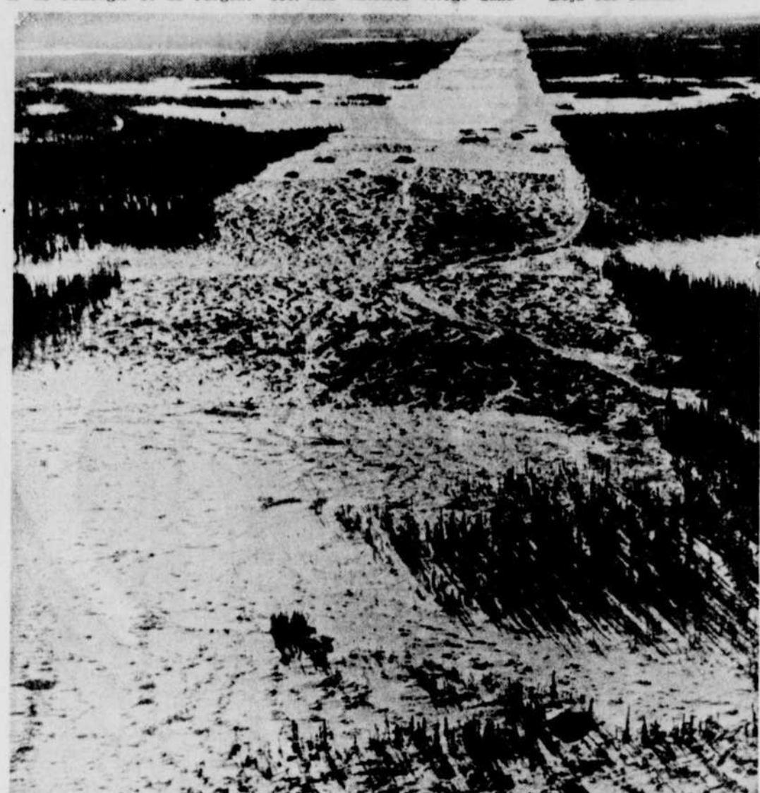
● LE PASSAGE DES LIGNES — Cette vue aérienne d'un passage large de 710 pieds indique la voie que prendront les trois lignes de transmission de 735,000 volts chacune, pour transporter l'électricité qui sera produite par l'usine hydroélectrique des chutes Churchill, dans le Labrador central. On prévoit commencer la livraison de l'énergie le 1er mai 1972, et parachever en 1976 les travaux de $950 millions. (Photo PC)
