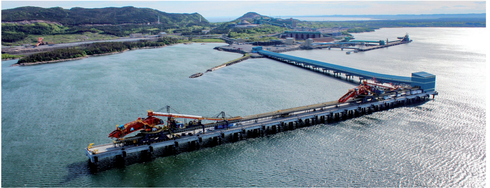
Le quai multiusager du Port de Sept-Îles est désormais accessible aux futurs utilisateurs. (Photo : Courtoisie)
