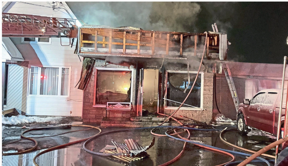
Un incendie a causé de lourds dégâts à un ancien dépanneur de Sainte-Claire tôt le dimanche 20 novembre. Photo gracieuseseté
