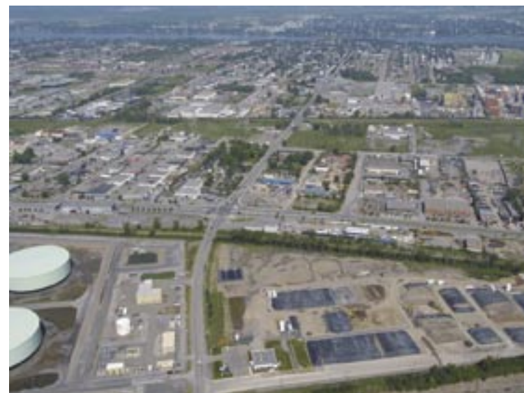
Parc industriel Rodolphe-Forget
