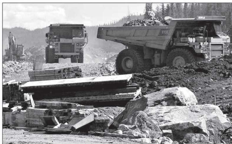
Le chantier de la route 175 — PHOTOTHÈQUE LE SOLEIL, ERICK LABBÉ
