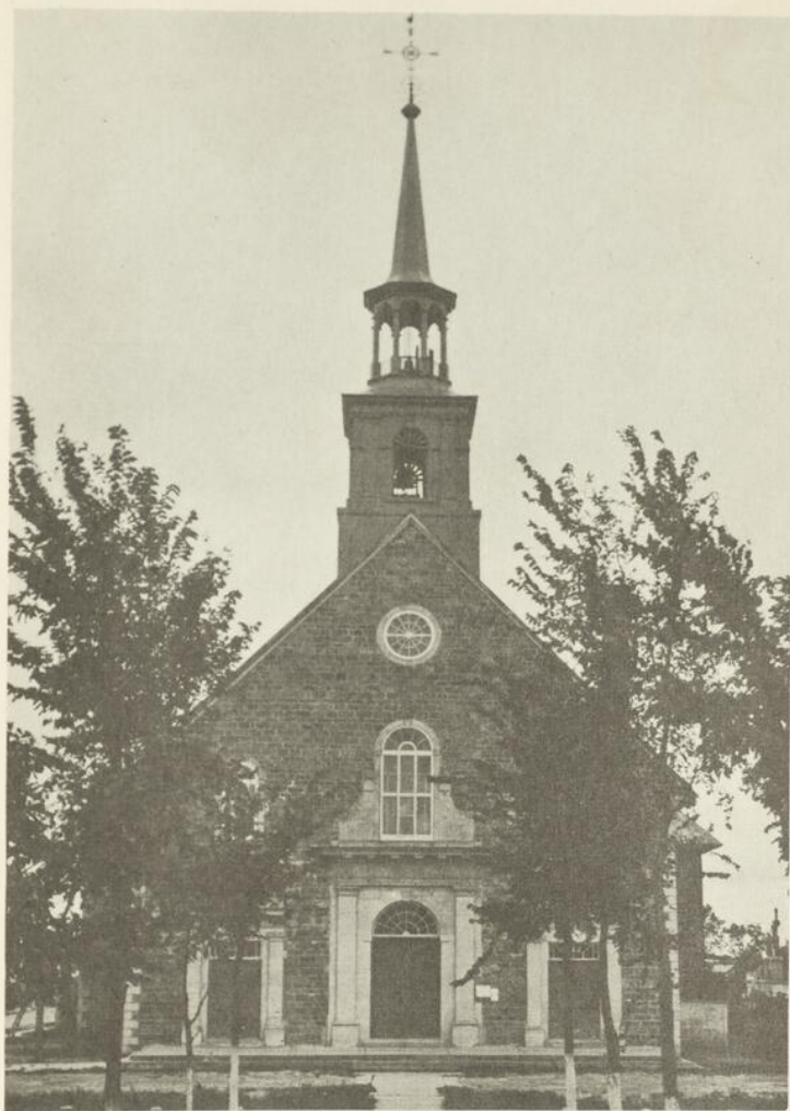
67. BECQUETS (Les) — Église Saint-Pierre, construite en 1838 par N. Larue d'après les plans de Thomas Baillaigé.
