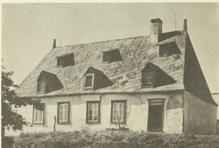
4a. SAINTE-FOY — Maison Blais construite vers 1735 et agrandie en 1792. Bel exemple de toiture en pavillon.
