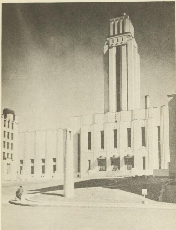
105. MONTRÉAL — Partie centrale et tour de l'Université construite de 1928 à 1942 d'après les plans et devis d'Ernest Cormier. — Les plans datent de l'année 1925.
