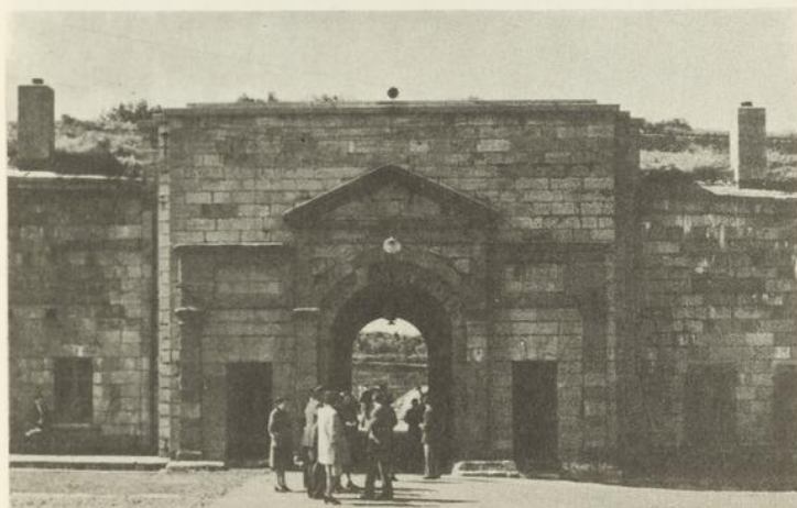
45a et b. QUÉBEC — Portails, extérieur et intérieur, de la citadelle, construits de 1823 à 1830 par les ingénieurs royaux, d'après les plans originaux de Gaspard Chaussegros de Léry.
