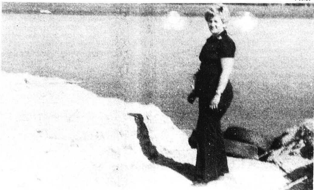
Due aux pluies abondantes des derniers jours, une crevasse s'est formée sur le terrain de M. Roland Dubé, résidant sur la 138, à la sortie de Berthierville. Nous faisant voir les dommages causés à leur propriété qui est minée par l'eau, Mme Dubé nous a mentionné avoir fait appel aux députés Mercier et Yanakis qui sont venus constater les dommages, mais dont la visite n'a eu aucune suite.
