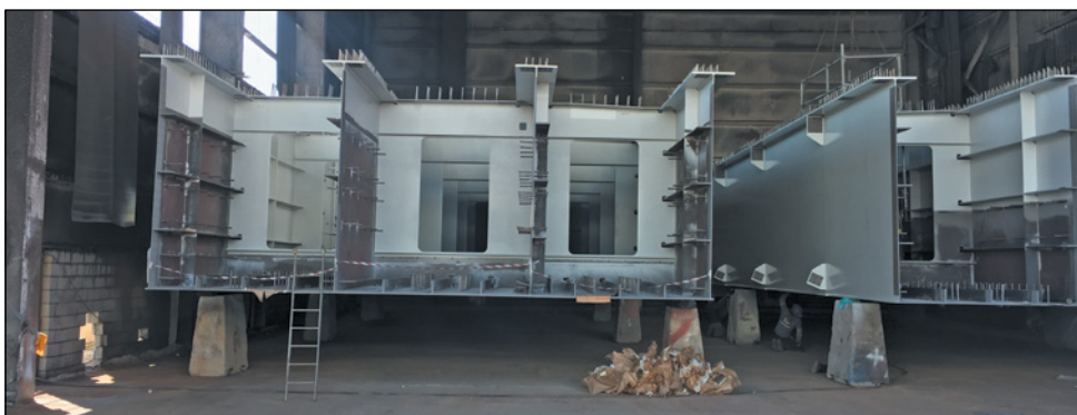
L'entreprise participe activement à la surveillance de fabrication de la superstructure d'acier de la partie suspendue du pont Champlain fabriquée à Séville et à Los Molares en Espagne.
