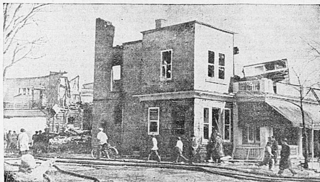
Voici dans quel état se trouve aujourd'hui l'une des sections de l'hôtel Lapointe, de Saint-Jérôme, par suite de l'incendie qui a ravagé cette hôtellerie dans la nuit de vendredi à samedi, causant des pertes évaluées à plus d'un demi-million de dollars. De la section principale, où il y avait une centaine de chambres, de l'annexe de la salle à manger et du grill, il ne reste que des poutres tordues.
