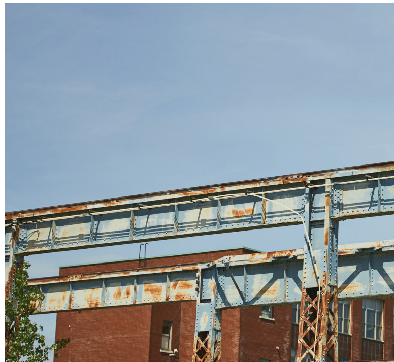
La professeure Sophie L. Van Neste, de l'INRS, pilote le projet Labo Climat Montréal, qui porte sur l'adaptation aux changements climatiques dans Lachine-Est, un écoquartier montréalais en développement. On peut voir sur cette photo des ponts roulants, patrimoine industriel iconique du quartier. • IMAGE : INRS / PHIL BERNARD
