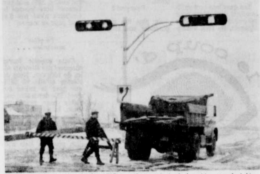
ENFIN OUVERTE A LA CIRCULATION — Des employés de la voirie ont enlevé hier les barrières qui empêchaient les véhicules d'emprunter le nouveau tronçon de la route 5, à la hauteur des villes de Victoriaville et Arthabaska. (Photo La Tribune, Victoriaville)
