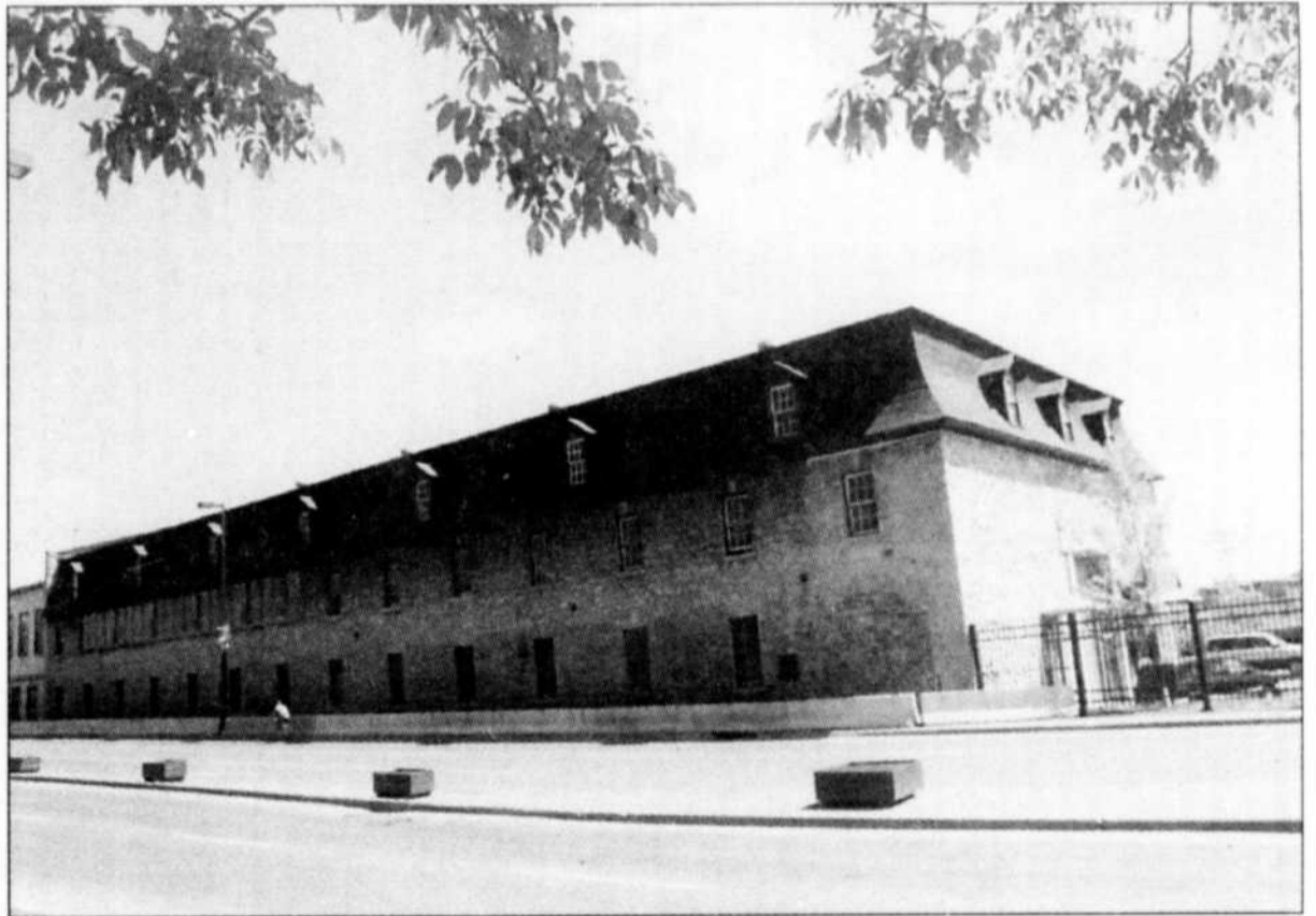
La compagnie E. B. Eddy et la Ville de Hull sont en désaccord depuis plusieurs mois à cause des bâtiments désaffectés de l'entreprise situés à l'angle d'Eddy et Taché
