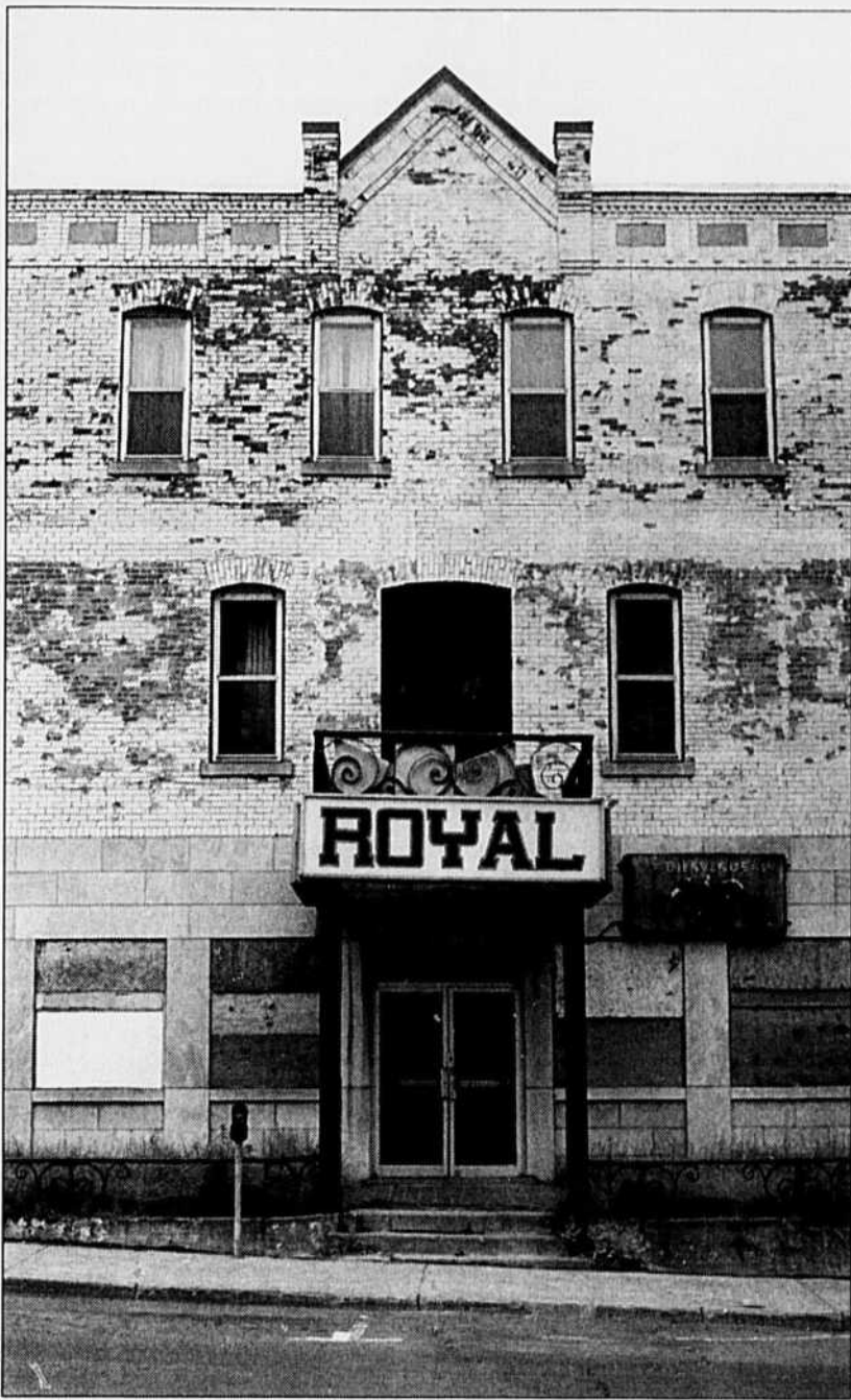
Le centre-ville de Shawinigan est en mauvais état. Des bâtiments désaffectés, une salle de cinéma à l'abandon... «C'est la mort ici», dit Josée, serveuse au Café la Pointe à Bernard.
