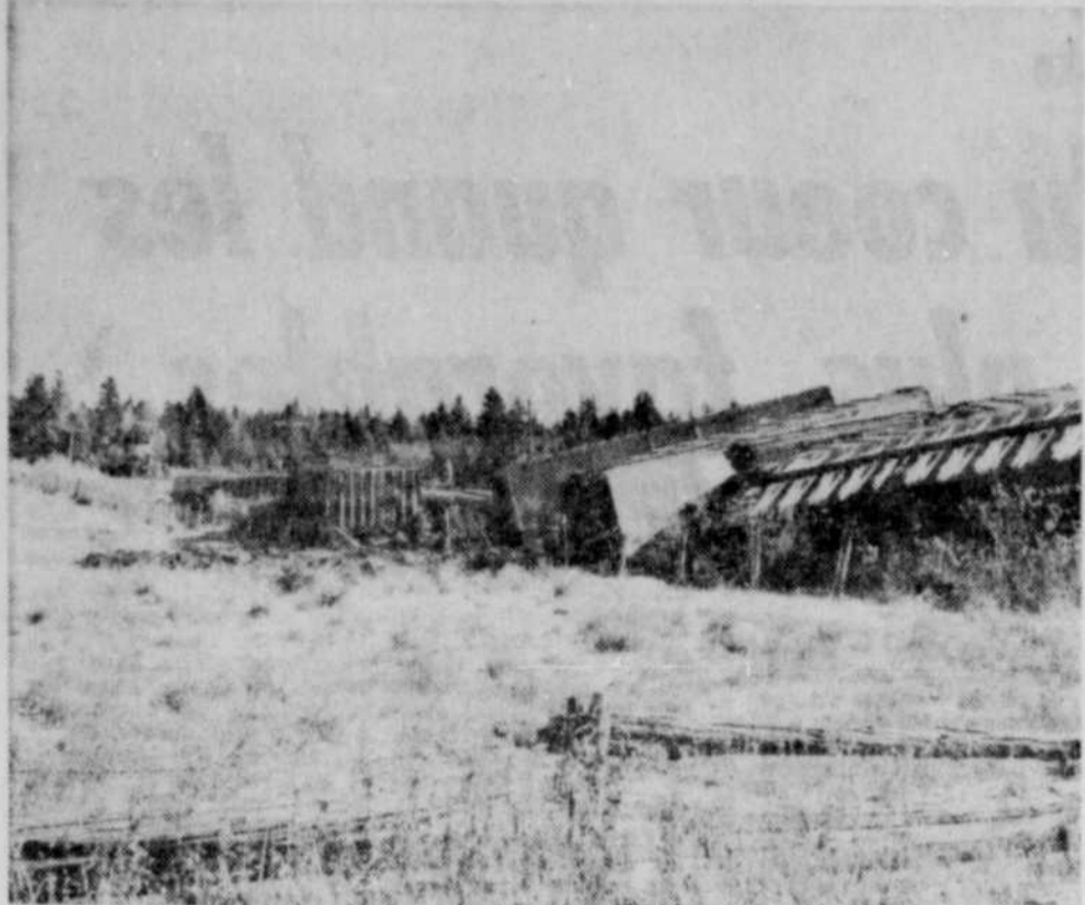
DERAILEMENT — Une scène indescriptible, donnant l'impression du passage d'un cataclysme, s'offrait à la vue des curieux accourus sur les lieux de l'accident ferroviaire qui a fait deux morts, hier avant midi, dans le rang St-Louis de St-Frédéric de Beauce. Le déraillement qui accompagna la macabre collision entraîna dans sa descente la locomotive, 12 wagons de marchandise et un wagon-citerne. La photo ci-haut illustre la scène.
