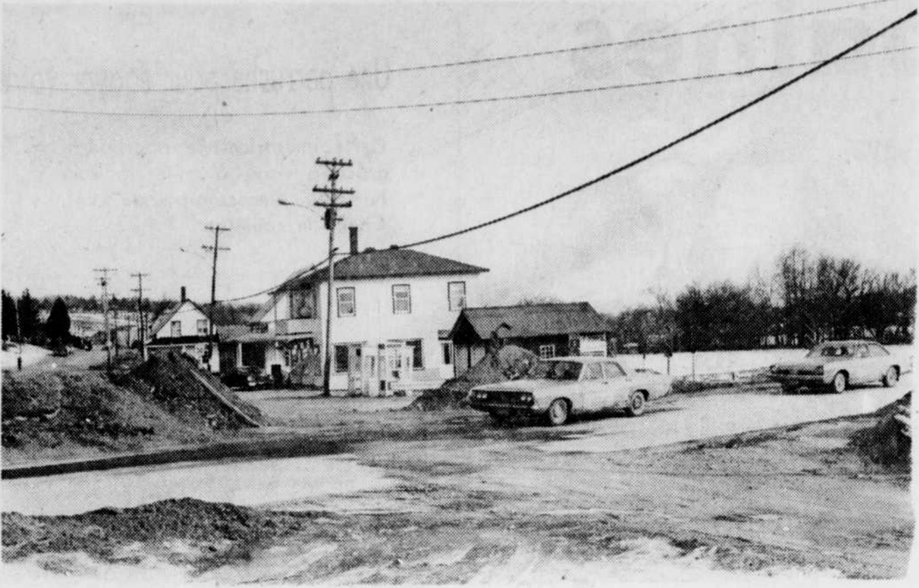
A l'intersection de la route 1 et de la rue principale à Ascot Corner, d'énormes tas de sable montent la garde. L'une des rues est en partie bouchée par les monticules et les automobilistes doivent tenter tant bien que mal de passer entre ces "piliers" de terre inusités. (Photo La Tribune, Doug Gerrish)
