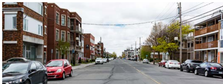
La phase 2 des travaux s'étend de la voie ferrée à la rue Saint-Jean.
