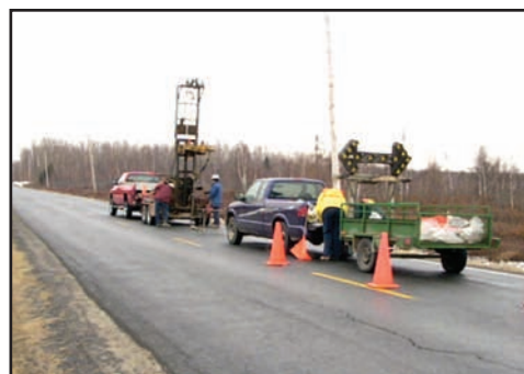
Figure 2 : Sondages d'infrastructures routières
