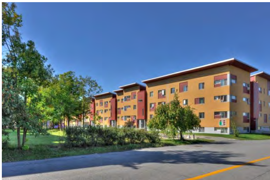
La coopérative d'habitation les Clairières du Mainbourg s'articule autour d'un grand espace vert. Crédit photo : Ville de Montréal
