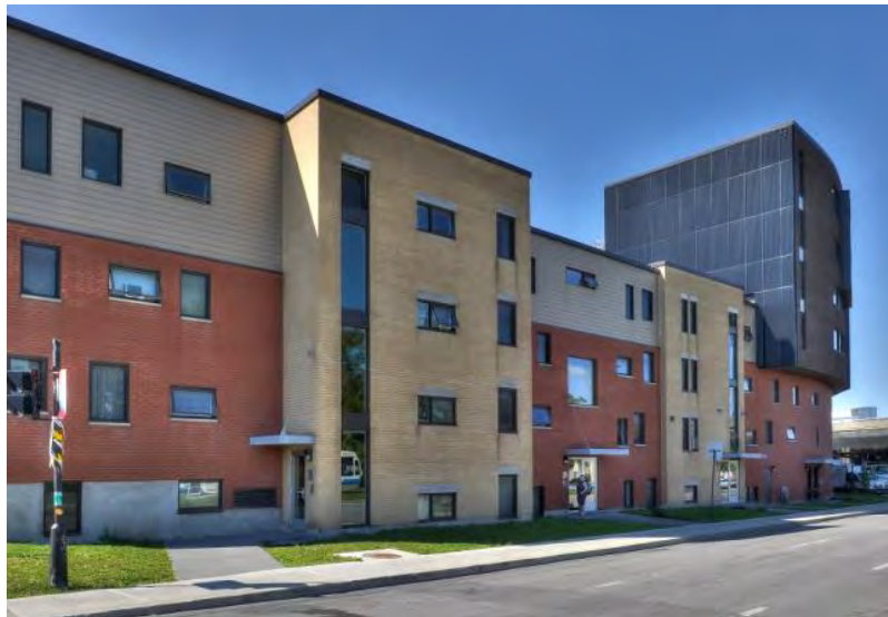
Vue sur l'immeuble de 26 unités dédié aux familles dont au moins un membre est une personne sourde. Crédit photo : Ville de Montréal
