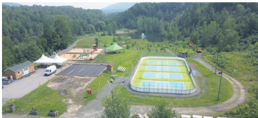
Les travaux d'aménagement du parc Gilbert-Aubin vont bon train. Anneau de glace, parc de jeux pour enfants, bancs, lumières, rond de feu officiel et jeu de pétanque sont en construction en ce moment
