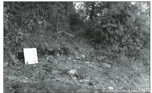
Photo 22 : Encoche dans le talus
