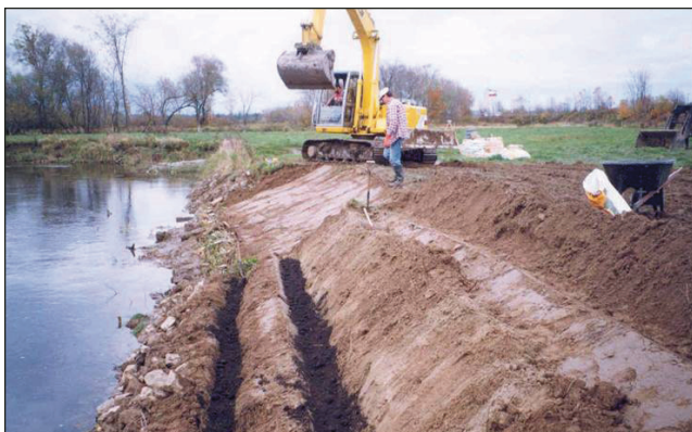
Photo 14: Travaux de stabilisation des rives : installation de fagots en bas de pente
