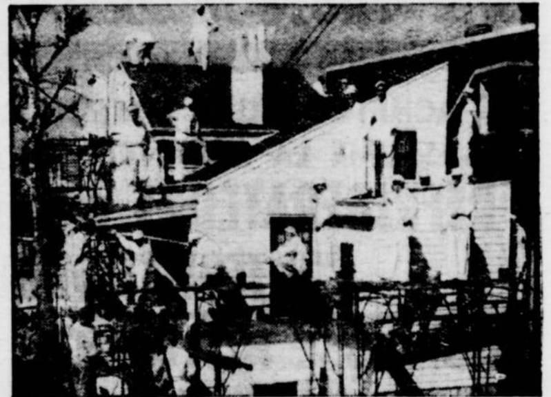
Les ouvriers ont beau être nombreux, cette maison n'est tout de même pas construite selon les données de la construction en série. C'est pourquoi le coût en est si élevé et que le gouvernement est obligé de plus en plus de financer l'industrie du logement.
