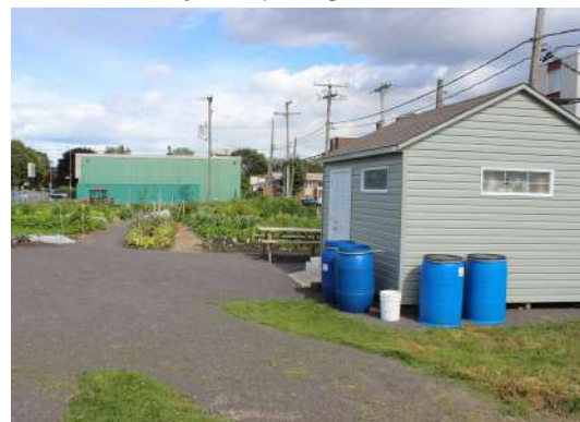
Figure 32 : Cabanon et bacs de récupération des eaux de pluie dans un jardin partagé
