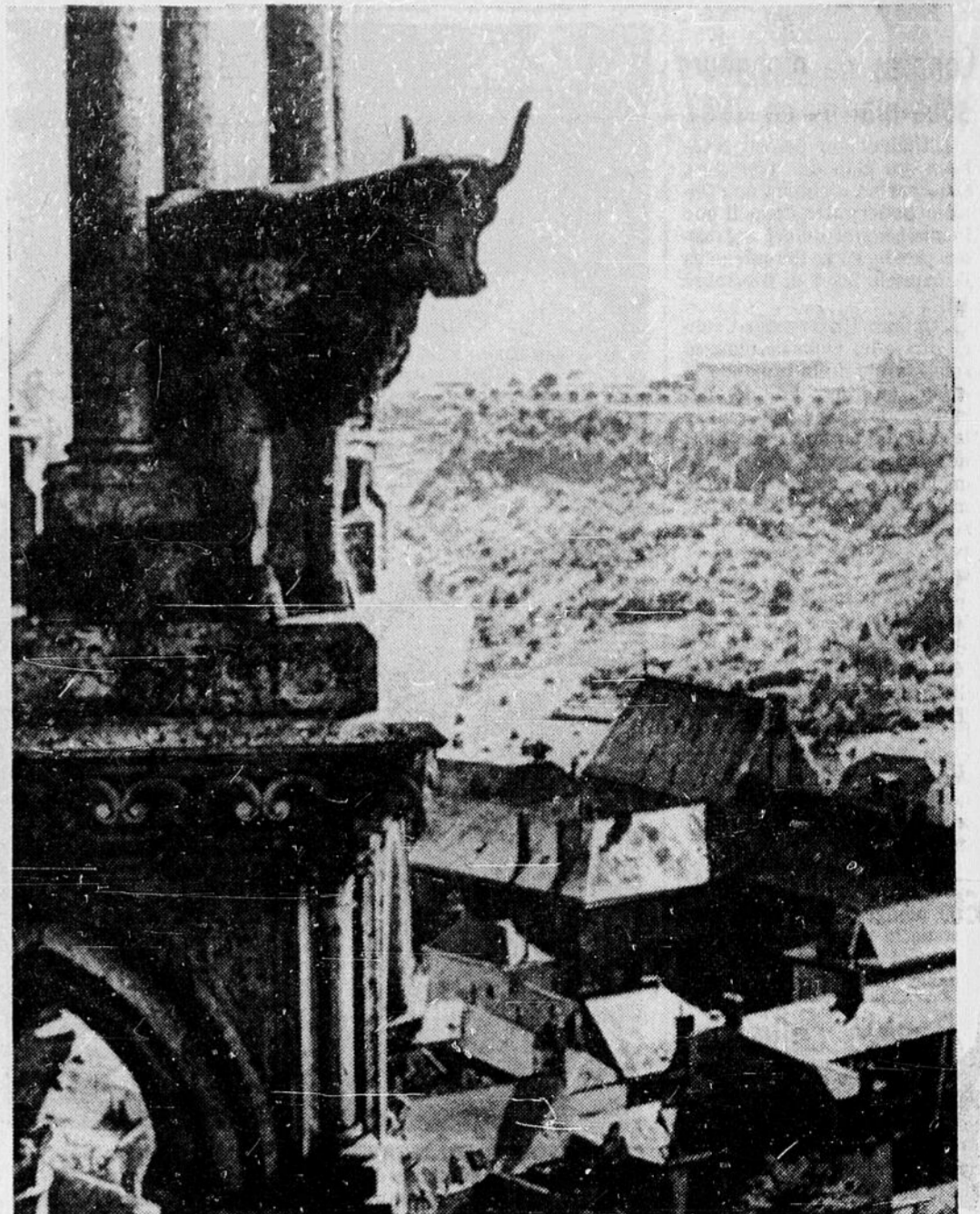
Mirail d'une époque, la cathédrale de Laon, dont la construction précéda celle de Notre-Dame de Paris, regarde au loin vers l'Aisne et les carrières d'où les bœufs ont charroyé pendant près d'un siècle les pierres qui ont servi à la construction, avant que de veiller, mis à l'honneur au flanc des tours, sur les toits de la ville. D'une richesse remarquable, plein de noblesse et présentant la somme des connaissances du Moyen-Âge, l'édifice nous est parvenu presque intact dans son état original. Son influence a été considérable dans le Nord et l'Est de la France, comme en Normandie et jusqu'en Angleterre, en Allemagne et en Espagne.
