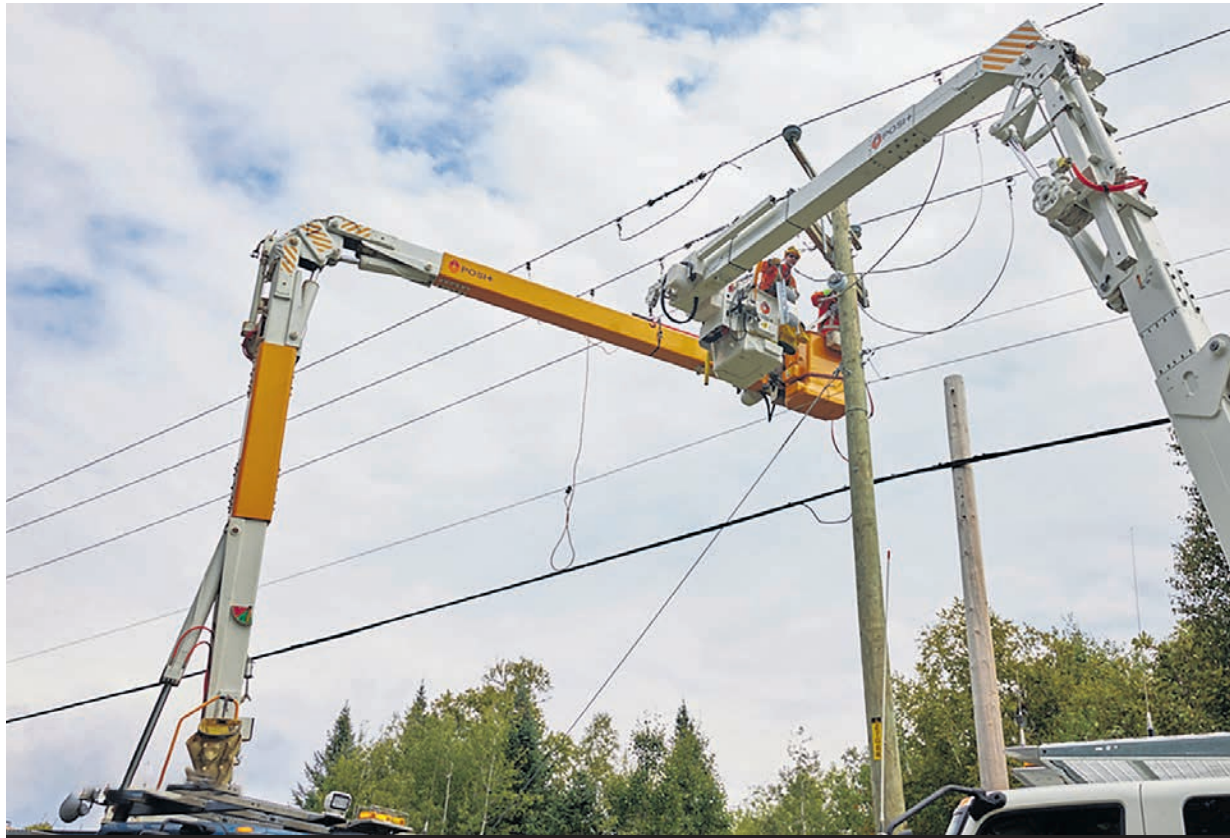
Lors de ces interruptions, des travaux de maintenance et de maîtrise de la végétation seront exécutés.
