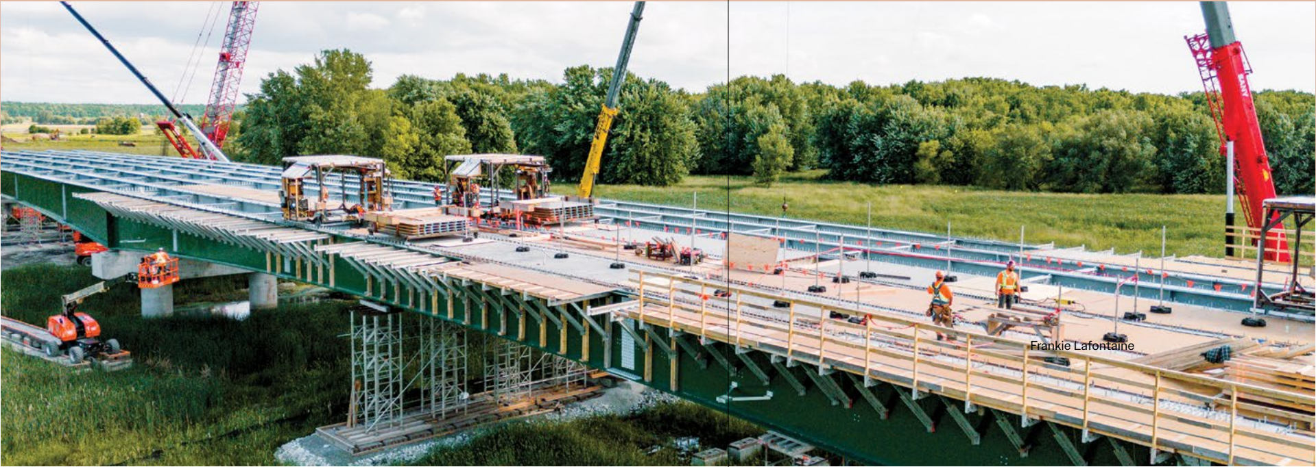
En réfléchissant à la sécurité des travailleurs qui devaient installer le coffrage du pont, le surintendant Jeannot Marceau a eu l'idée d'un chariot motorisé qui servirait de plateforme de travail mobile.
