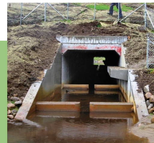
Passage faunique pour les mammifères de taille moyenne le long de la route 175. La clôture de part et d'autre du passage guide les animaux vers la tablette en béton.
