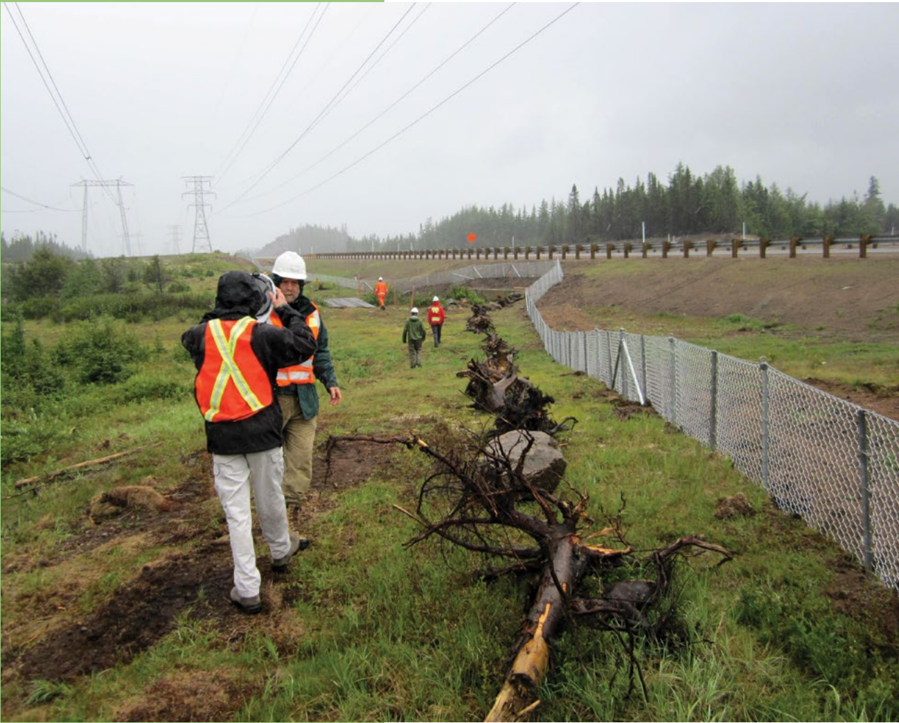
Clôture à faune le long de plusieurs tronçons de la route 175, destinée à guider les mammifères de taille moyenne vers le passage faunique installé au centre des tronçons clôturés.
