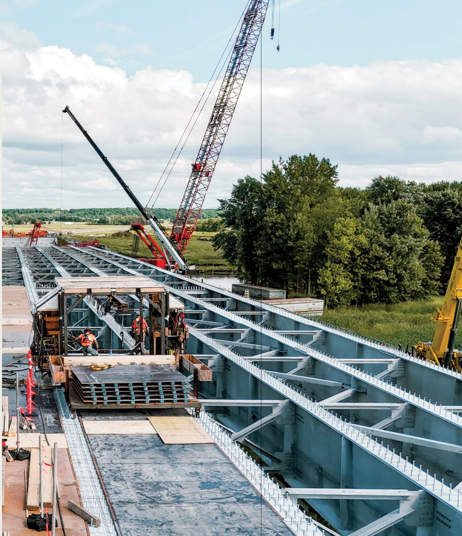
Le chariot motorisé mis en place sur le chantier de la rivière aux Brochets a permis d'accélérer le travail tout en assurant la sécurité des équipes.
