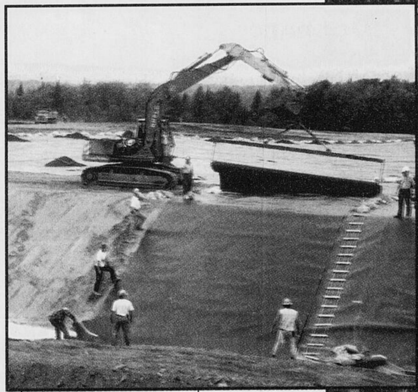
Photos, ministère de l'Environnement et de la Faune Pour réhabiliter le site de l'ancienne mine Weedon, à Fontainebleau, les résidus ont été amassés en deux capsules différentes et recouvertes d'une géomembrane. À droite, une vue aérienne d'une des deux capsules, recouverte d'une géomembrane et où on y a semé des graminées, montre l'amélioration du secteur de la vieille mine de Fontainebleau.
