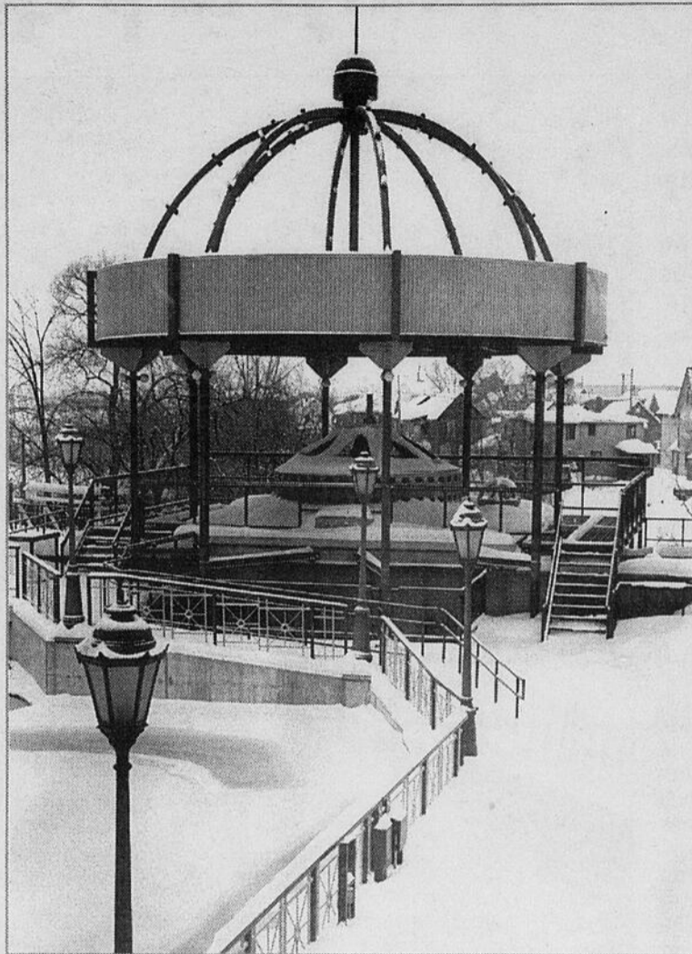
La turbine de la rue Montcalm à Hull.
