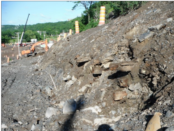
Photo 10 Vue vers l'ouest de pièces de bois dans la côte de Sillery (VDQ1604-NUM1-158)
