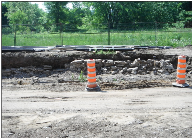
Photo 18 Premiers segments dégagés du mur de soutènement CeEt-943-1C6 en face à l'ancien garage municipal, vue vers le sud (VDQ1604-NUM1-132)
