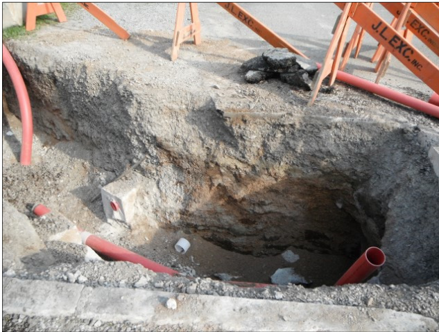
Photo 3 Excavation dans la rue du Cardinal-Persico, vue vers le nord (VDQ1604-NUM1-128)
