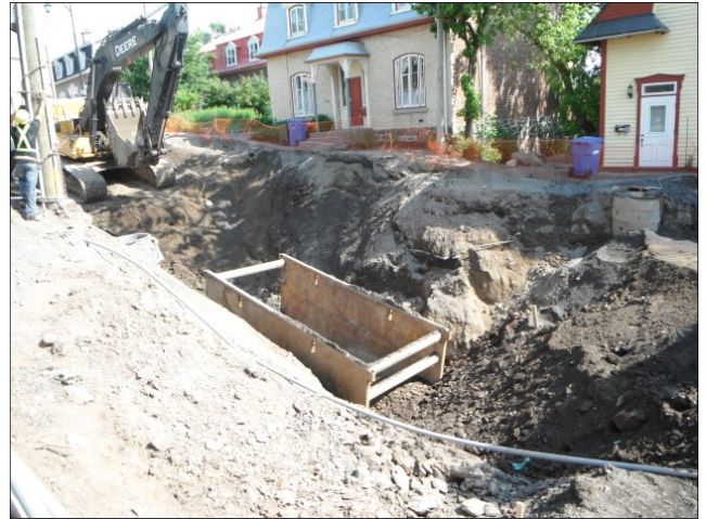
Photo 4 Excavation dans la côte de Sillery près de l'église Saint-Michel, vue vers le nord-est (VDQ1604-NUM1-254)
