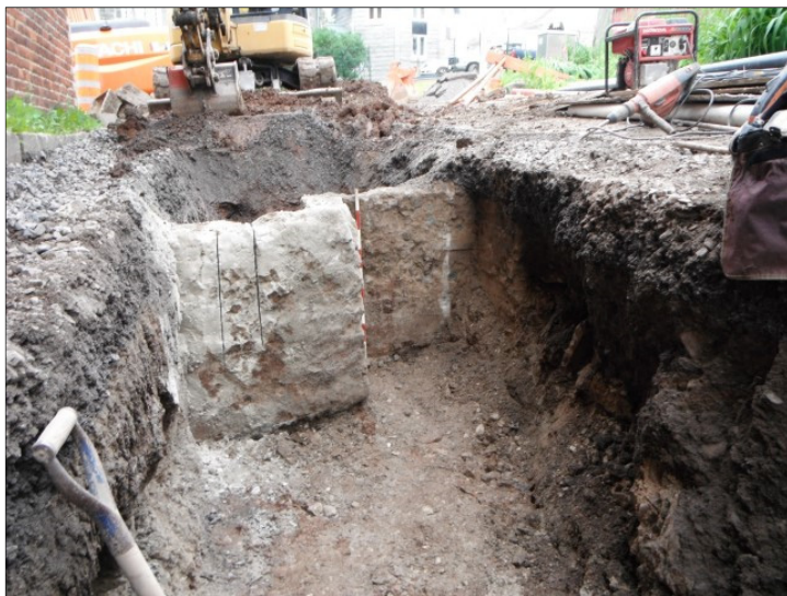
Photo 8 Décrochement dans la fondation du laboratoire qui correspondrait à l'entrée principale, vue vers le nord-ouest (VDQ1604-NUM1-207)
