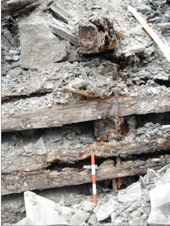
Photo 13 Aperçu de l'assemblage des caissons de bois et de leur gabarit (VDQ1604-NUM-177)
