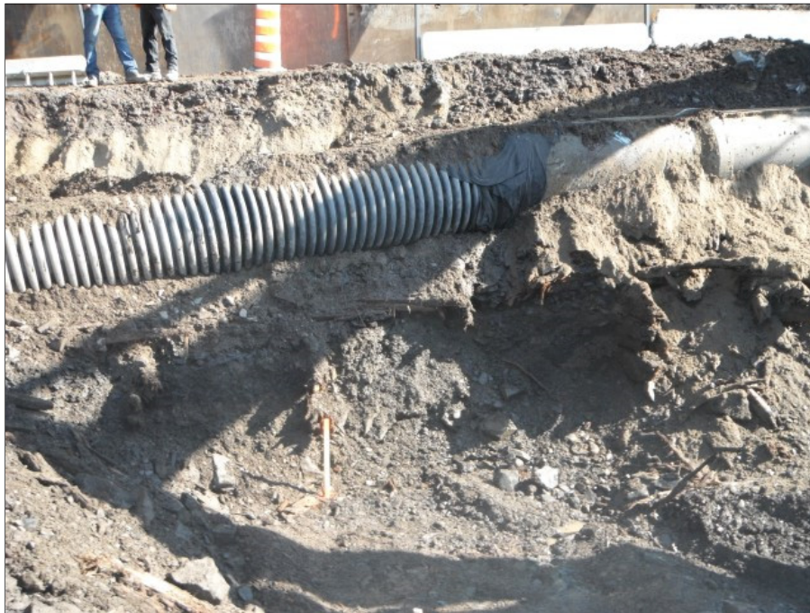
Photo 9 Vue vers le nord de pièces de bois sous la conduite d'eau usée (VDQ1604-NUM1-94)
