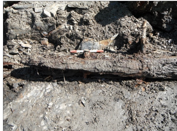
Photo 11 Vue vers l'ouest de la technique d'ancrage des caissons dans la côte (VDQ1604-NUM1-162)
