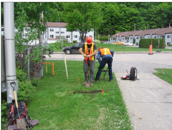
Photo 30 Vue vers le nord de l'emplacement de la sous-opération VDQ1604-2B (VDQ1604-NUM2-9)
