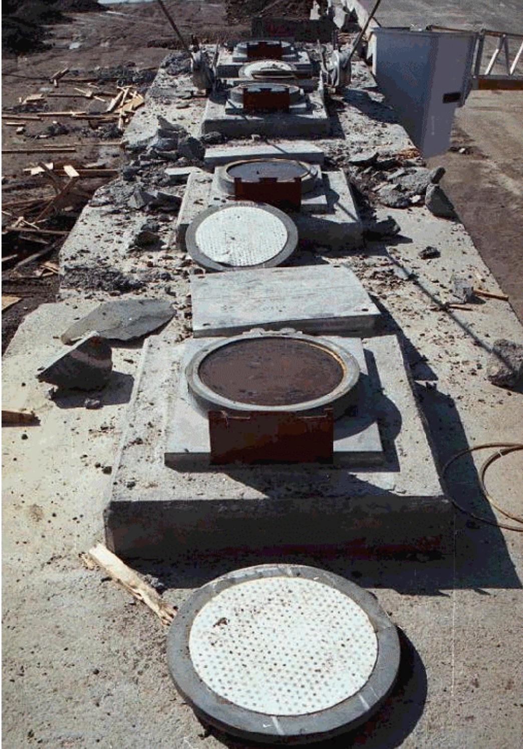
Figure 3.19 Extrémité sud de la pile 4 après enlèvement des poutres de la travée 4 (photo 330.8.08)
