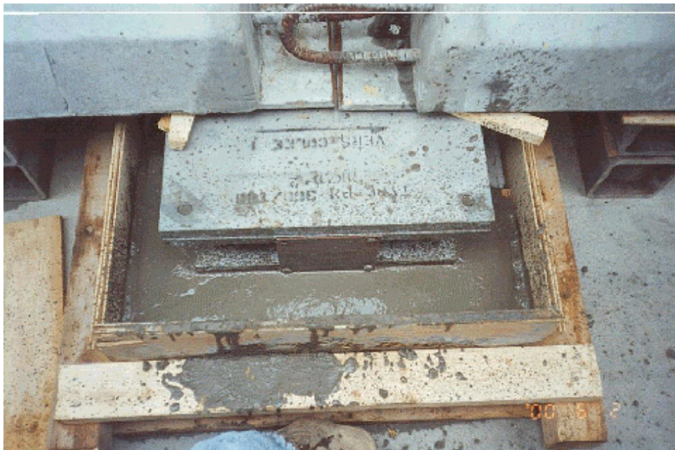
Figure 2.14 Allongement des socles de béton et déplacement des appareils d'appui à la pile 3 (Photo DES.151)
