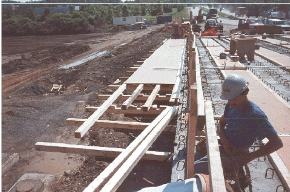
Figure 2.28 Coffrage du porte-à-faux du côté sud, sur la travée 1 (photo DES.204)
