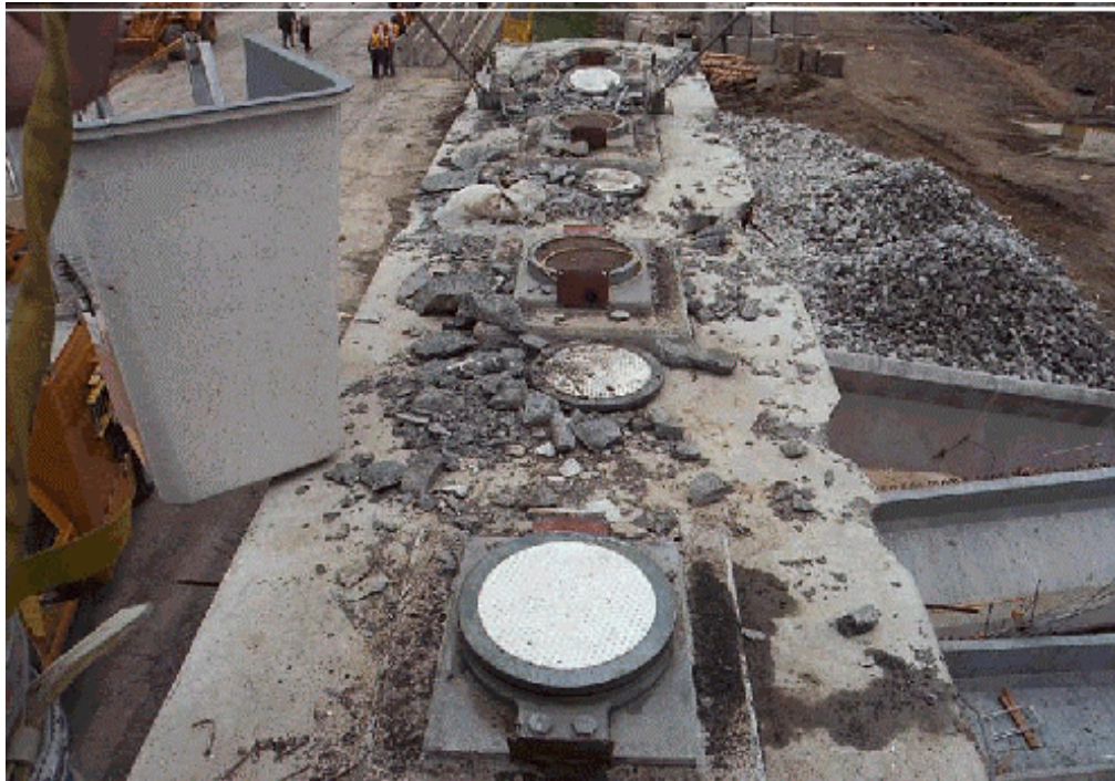
Figure 3.24 Vue de l'extrémité sud de la pile 2 (photo 280.3.01, prise après enlèvement des poutres de la travée 1)
