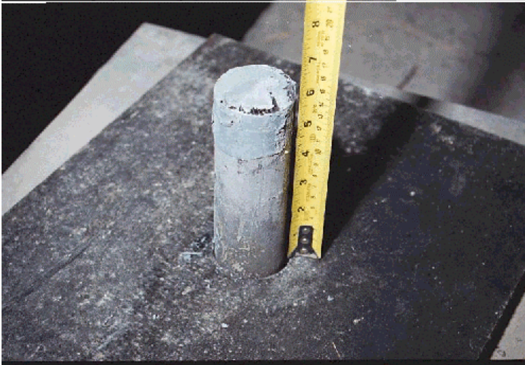
Figure 3.31 Tige d'ancrage des poutres 5 à 8 à la culée 1 (photo 280.9.18)
