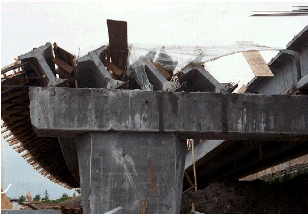
Figure 3.14 Vue rapprochée du bout des poutres de la travée 1 à la pile 2 (photo 308.2.20)
