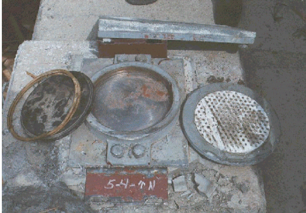
Figure 3.22 Composantes de l'appareil d'appui de la poutre 4 à la culée 5 (photo 280.5.07)
