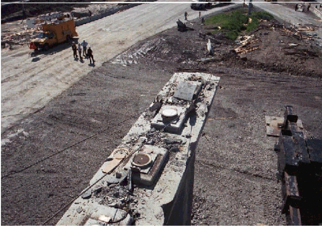
Figure 3.23 Vue de l'extrémité sud de la pile 3 (photo 280.1.19)
