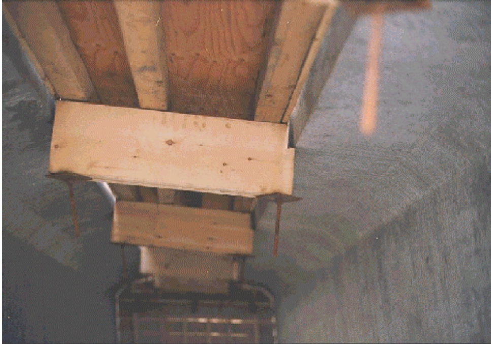
Figure 2.25 Coffrage de la dalle entre les poutres (photo 280.8.20, prise après l'accident)
