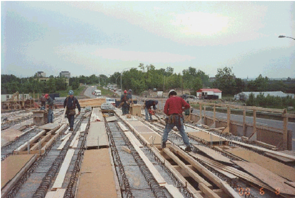
Figure 2.24 Construction du coffrage du tablier entre les poutres sur la travée 4 (photo DES.159)
