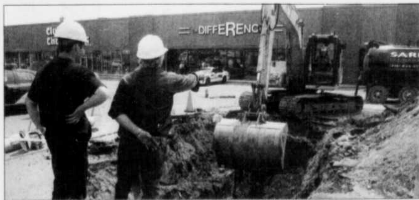
Travaux à Place Kennedy pour identifier la source du problème. Quinze personnes ont été hospitalisées hier en raison d'une fuite, soit autant que la veille.
