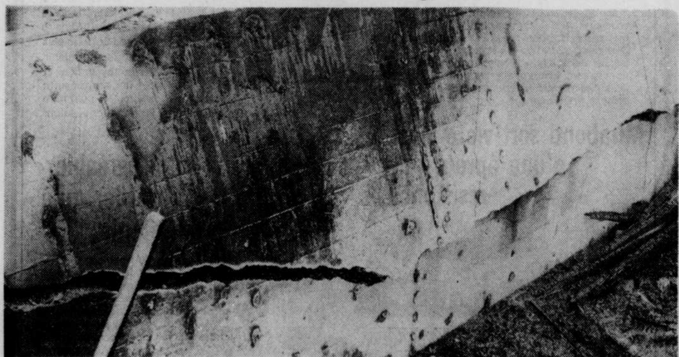
Les fondations de la maison Létourneau
