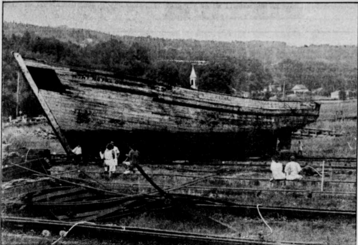
La goélette Mont Notre-Dame a tenu le coup : à l'aide d'un vieux système de treuils qui n'avait pas servi depuis 20 ans, on l'a déplacée latéralement d'une vingtaine de mètres. Cette structure fait quand même plus de 200 tonnes.
