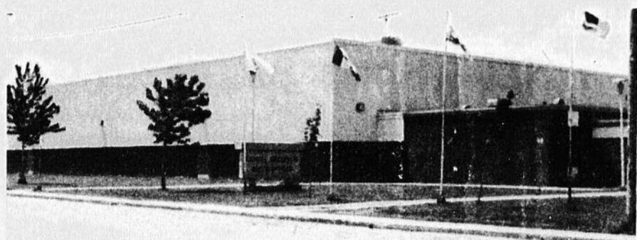
Le centre Gilles-Villeneuve: Berthierville pourrait profiter des argents non-utilisés dans le cadre du projet La Prade afin de le rendre plus utile encore à la population. Photo A.B.
