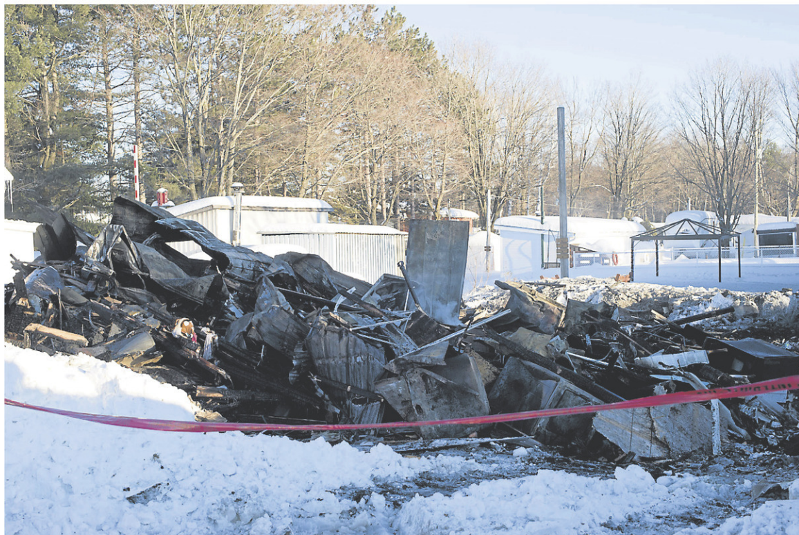
La résidence des propriétaires du camping Les lions d'or à Saint-Étienne-des-Grès a complètement été détruite par un incendie, mercredi matin. Elle servait aussi de bureau d'accueil pour le camping. — PHOTO: SYLVAIN MAYER
